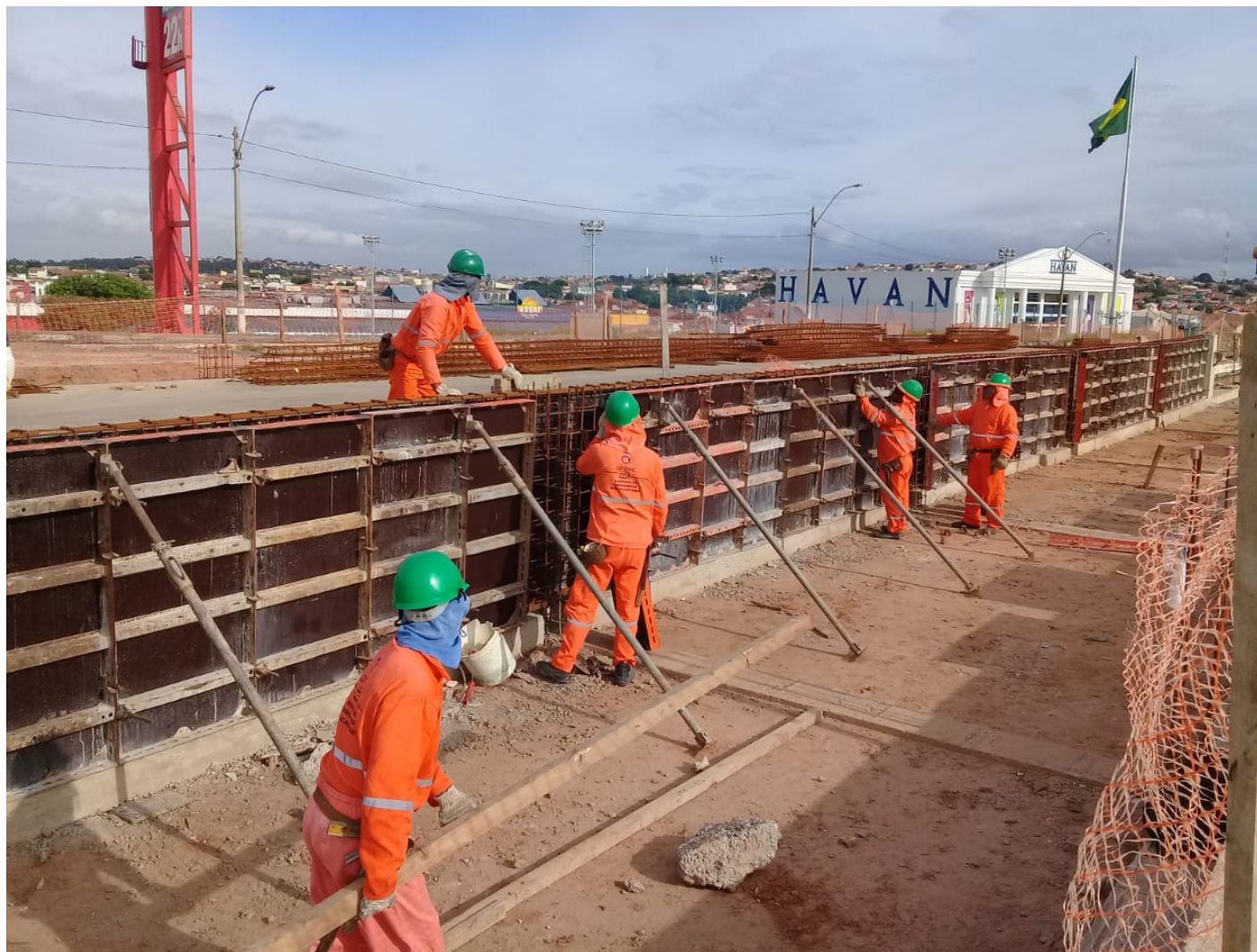
ESTRUTURA DA ESTAÇÃO SANTA LÚCIA MARÇO/2019
