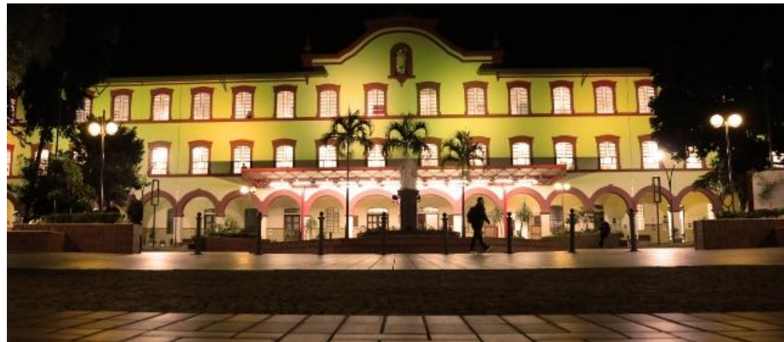
Fachada da Unisal iluminada
