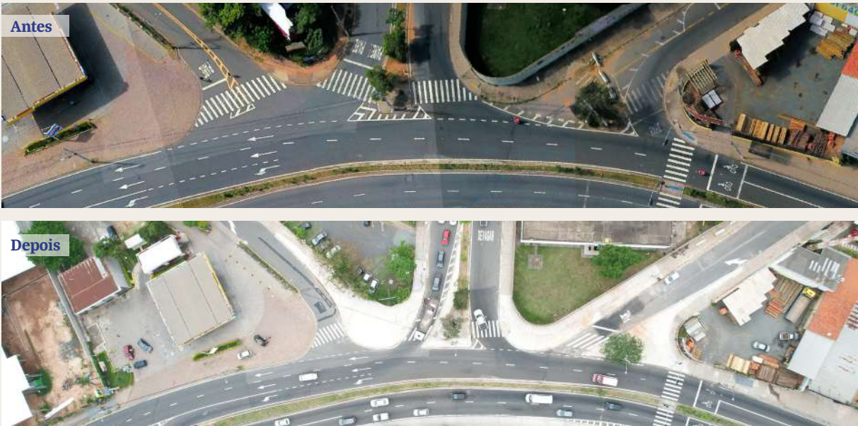
Figura 72: Fotos aéreas do antes e depois das intervenções de segurança viária no ponto mais crítico de Campinas: cruzamento entre a rua Tom de Araújo, marginal da Avenida John Boyd Dunlop, e a Avenida Prof. Mário Scolari. Foram realizados aumento dos passeios para pedestres, diminuição do raio de giro nas esquinas e alteração nos sentidos de circulação. Foto: Emdec.
