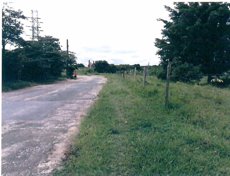
Foto 01. Vista do trecho de intervenção em APP nº 01, para a implantação da ciclovia - Parque Linear do córrego Bandeirantes.
