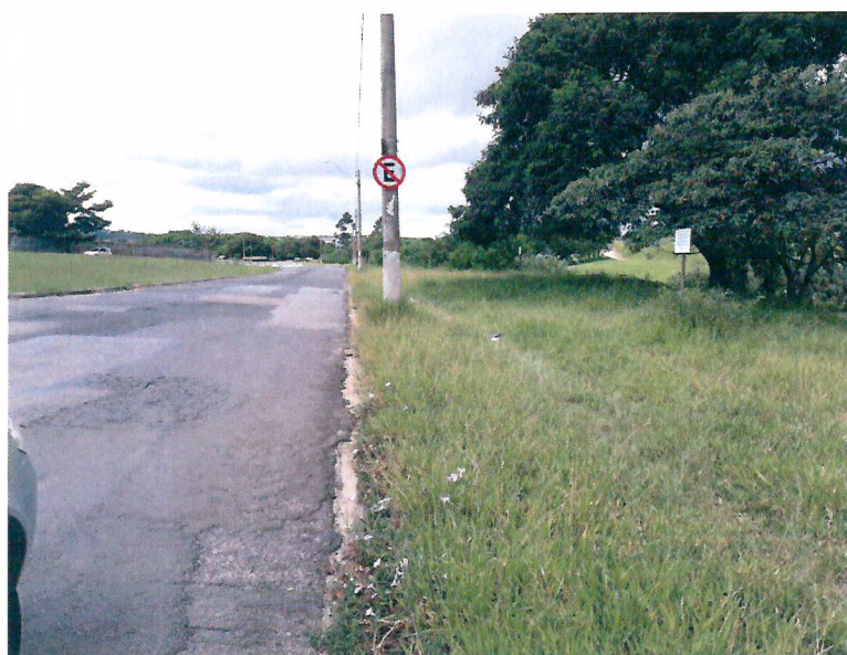
Foto 02. Vista do trecho de intervenção em APP nº 02, para a implantação da ciclovia - Parque Linear do córrego Bandeirantes.
