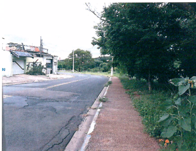
Foto 12. Vista do trecho de intervenção em APP nº 08, para a implantação da ciclovia - Parque Linear do córrego Bandeirantes.
