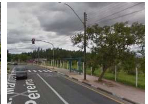
R. Manoel Pereira (Calçada sem pavimentação)
