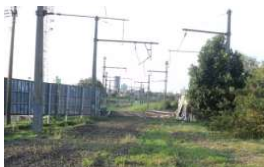
(1) Leito Desativado VLT, viaduto sobre a Av. John Boyd Dunlop Fonte: TTC (2016).
