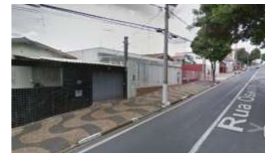
Av. J.B. Dunlop (Calçada regular em subtrecho com via paralela) Fonte: Google Street View (2015)
