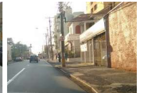
R. Dr. Sales de Oliveira (Calçada irregular e sem acessibilidade) Fonte: Google Street View, 2015
