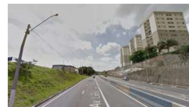
Av. Lix da Cunha (Residencial Vertical) Fonte: Google Street View, (2015).
