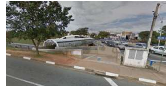
Av. Lix da Cunha (Acesso a Estação Balão do Tavares, calçada incompleta) Fonte: Google Street View (2015)
