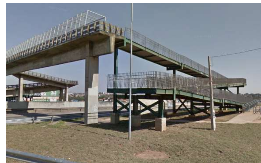
SP-101 (Passarela conectando áreas urbanizadas dos dois lados da via)
