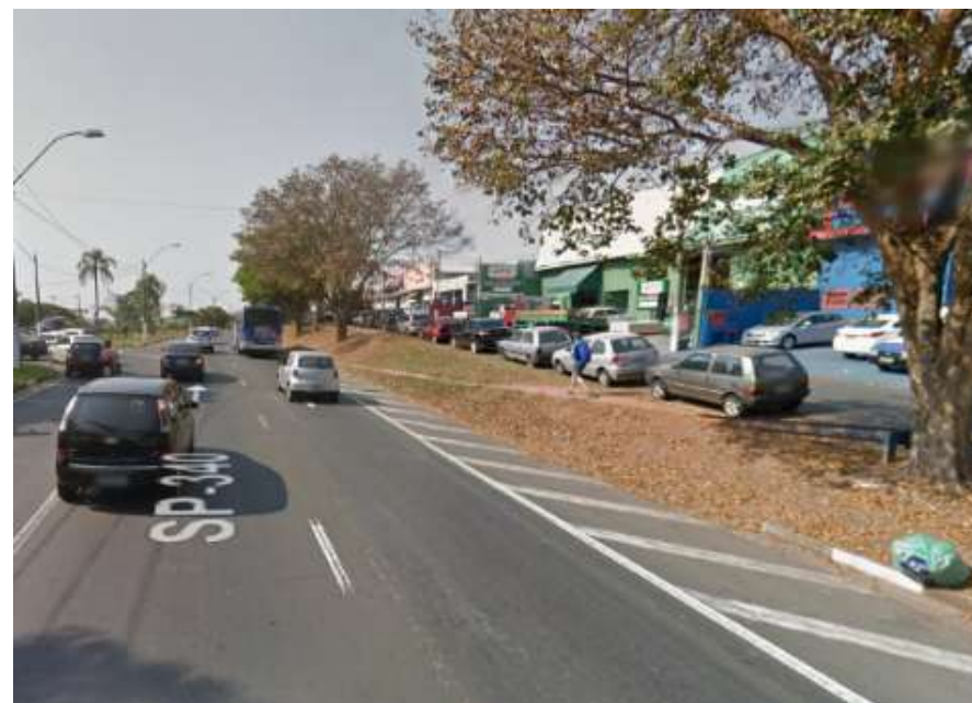
Trecho sem calçamento e de difícil acesso ao pedestre - R. Bento A. Camargo (Jd. Santana)
