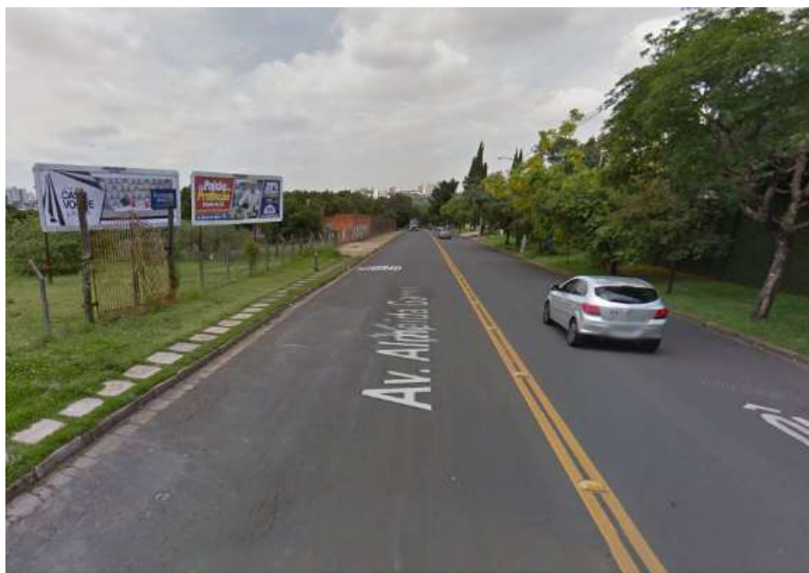
Lotes vazios e falta de calçamento em parte da via - Av. Almeida Garret (Alto Taquaral)
