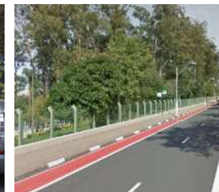
Av. Dr. Heitor Penteado: ausência de permeabilidade. Fonte: Google Street View (2015)
