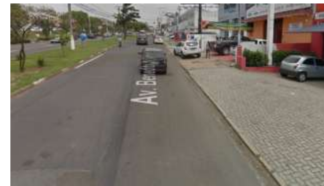
Continuidade da calçada - Av. Benedito de Campos (Jd. do Trevo) Fonte: Google Street View (2015)
