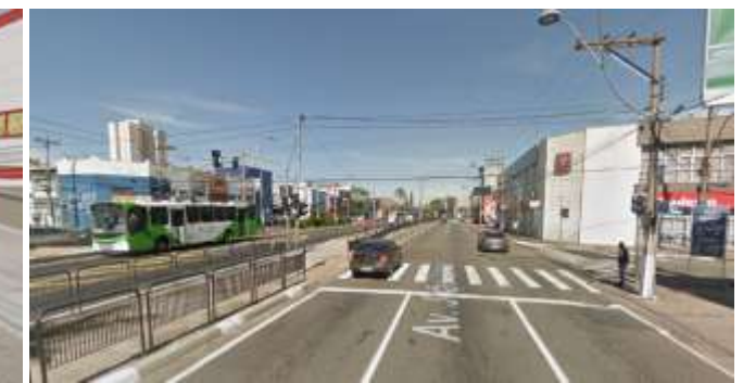
Uso misto e travessia sinalizada - Av. João Jorge (João Jorge) Fonte: Google Street View (2015)
