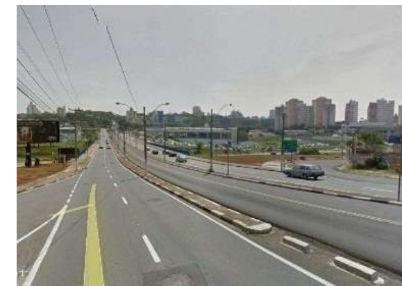
Av. Amoreiras, transposição ao leito ferroviário. Fonte: Google Street View (2015)
